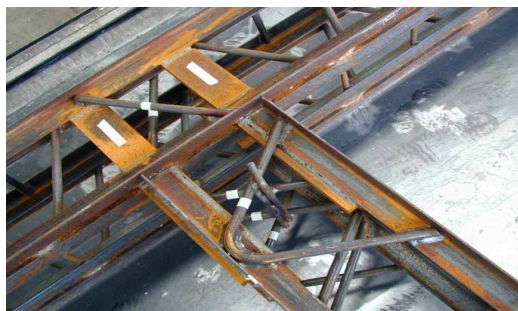
Fig. 18 Particolare del sistema metallico in corrispondenza del giunto trave - pilastro.
