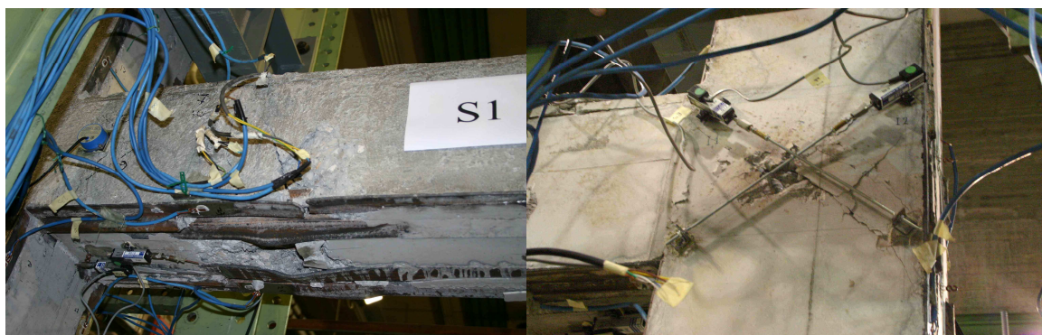
Fig. 23 Espulsione del calcestruzzo e taglio di un angolare.
