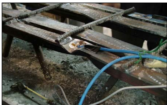
Figura 7. Instabilità locale sulla trave sperimentale
